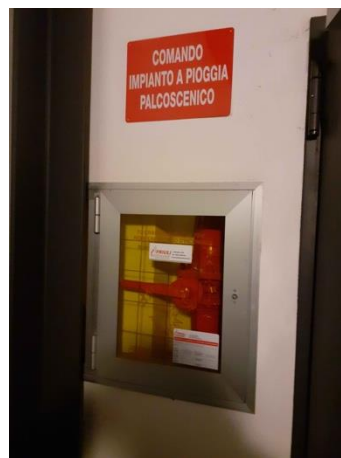
Valvola apertura impianto a pioggia palcoscenico
