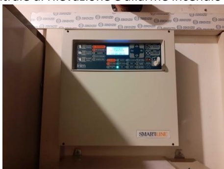
Centrale di rilevazione e allarme incendio
