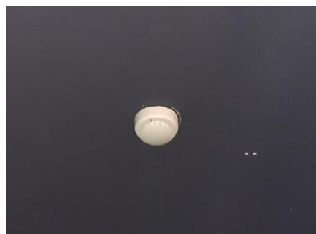
Rilevatore ottico di fumo puntiforme
