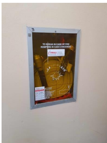
Idrante a muro DN 45 esterno
