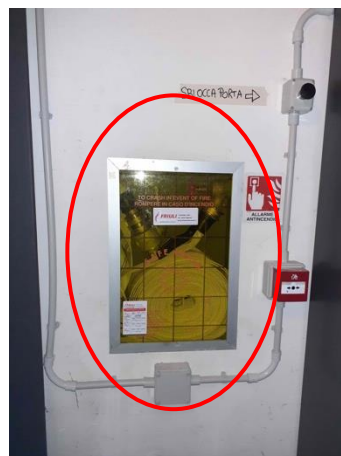
Idrante a muro DN 45 interno
