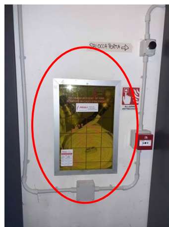
Idrante a muro DN 45 interno
