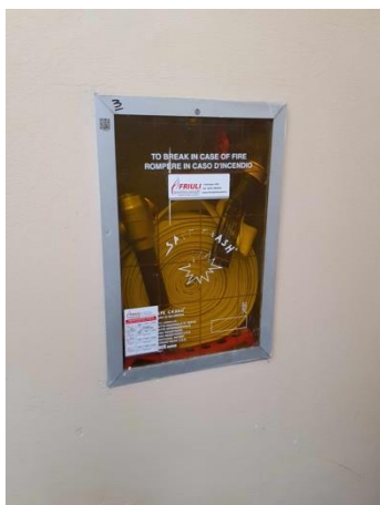
Idrante a muro DN 45 esterno
