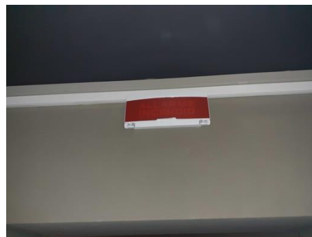
Pannello ottico-acustico di allarme incendio
