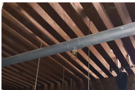
Testina sprinkler dell'impianto a pioggia
