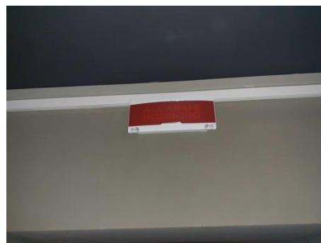
Pannello ottico-acustico di allarme incendio
