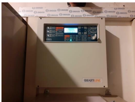
Centrale di rilevazione e allarme incendio
