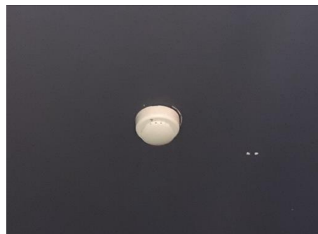
Rilevatore ottico di fumo puntiforme
